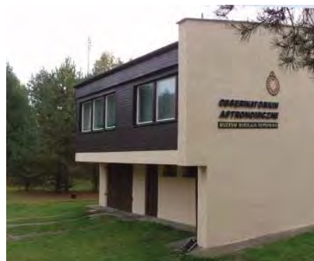
Budynek obserwatorium astronomicznego na Górze Żurawiej
