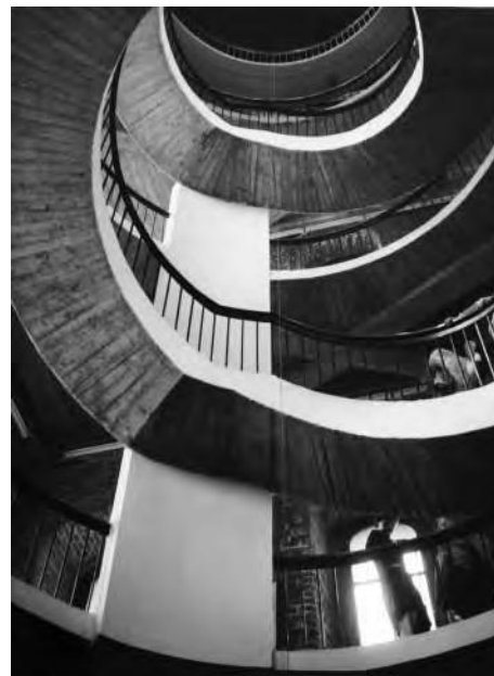
Żelbetowa, spiralna konstrukcja schodów w dzwonnicy
