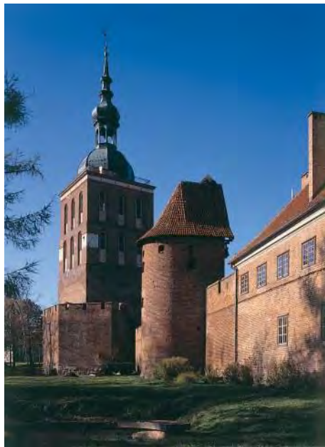
Widok na południowy odcinek Wzgórze Katedralnego (część zachodnia). W kolejności: Nowy Wikariat, Baszta Prochowa, dzwonnica osadzona na oktagonальной wieży artyleryjskiej
