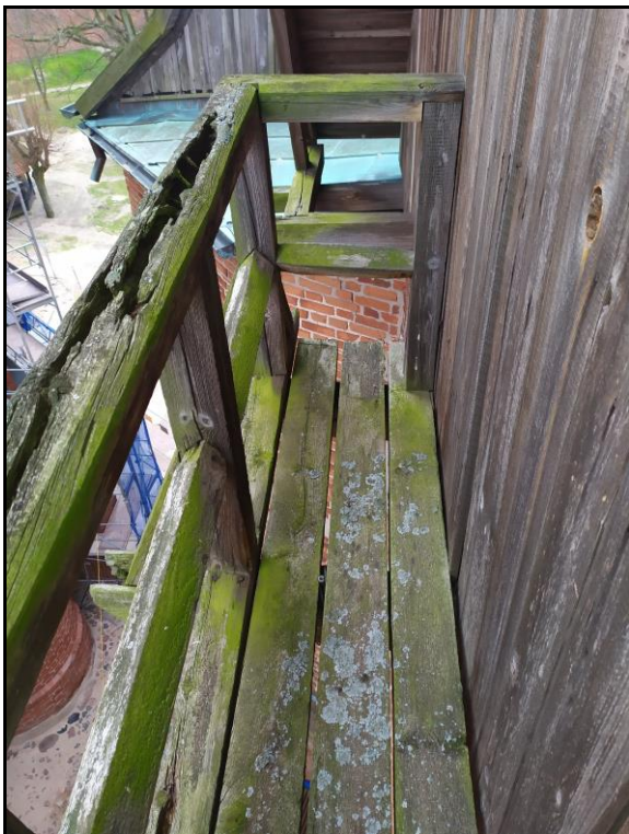
Fot.21, 22 Skorodowana i zdegradowana konstrukcja balkonu przylegającego do elewacji południowej Baszty
