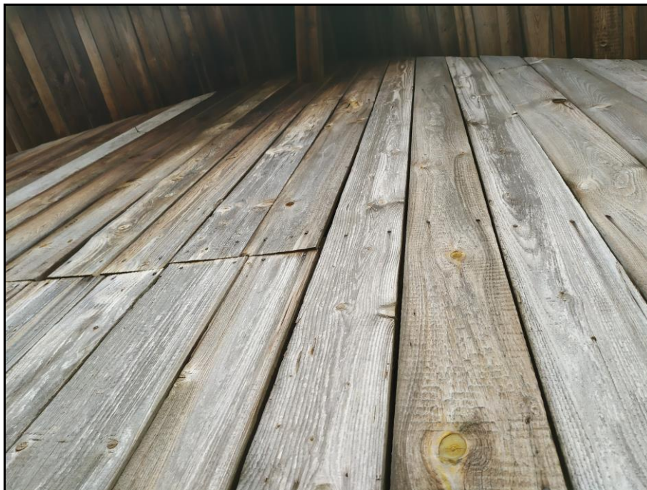
Fot. 19 Odeskowanie ściany szczytowej południowej baszty
