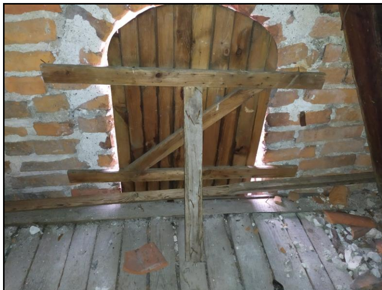
Fot. 28 Zabezpieczenie otworu okiennego (ściana zachodnia)
