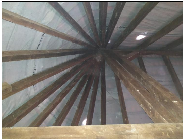
Fot. 11 Widok górnej części- szczytu konstrukcji więźby (dostateczny stan zachowania)
