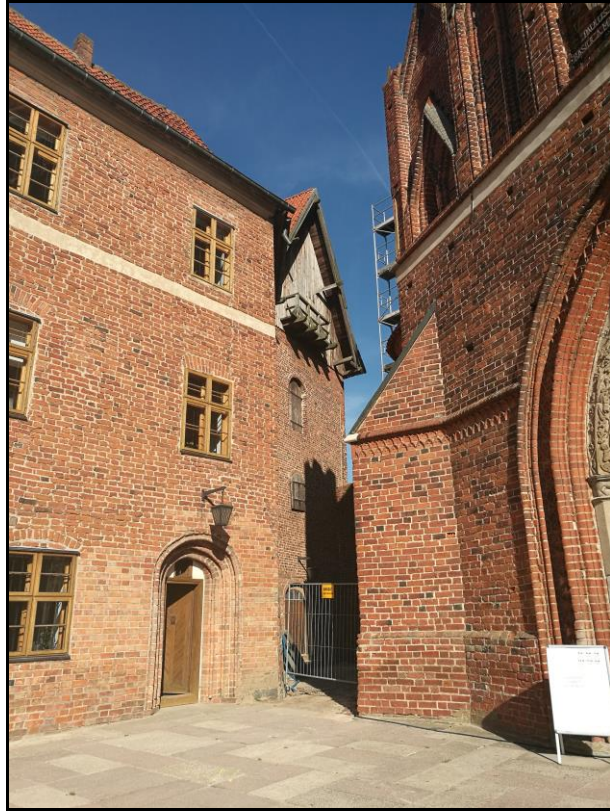
Fot. 3 Widok elewacji południowej Domu Kustosza i Baszty Kustodii z widocznym odeskowanym szczytem
