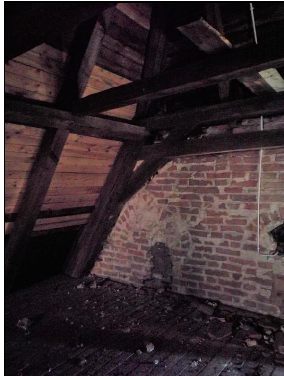
Fot. 5 Dom Kustosza- fragment widoku poddasza i konstrukcji więźby dachowej
