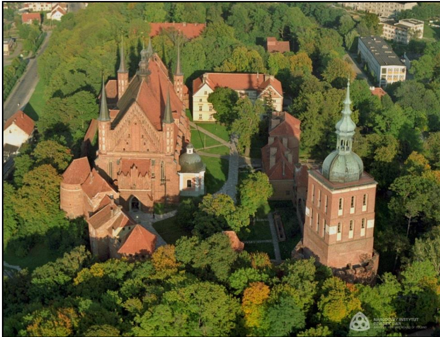
Fot. 1 Wzgórze Katedralne we Fromborku z widocznymi dachami Domu Kustosza i Baszty Kustodii 9
