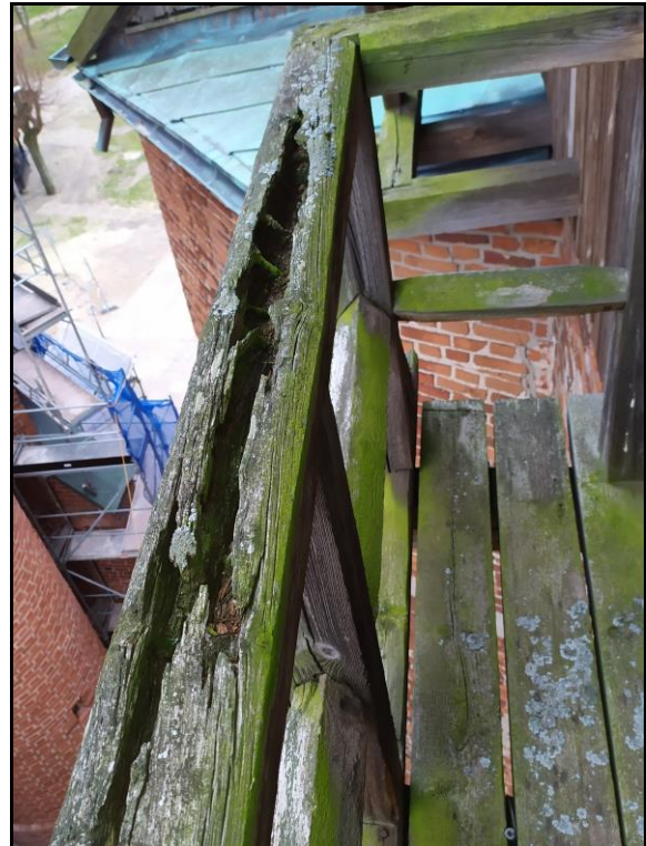
Fot.21, 22 Skorodowana i zdegradowana konstrukcja balkonu przylegającego do elewacji południowej Baszty
