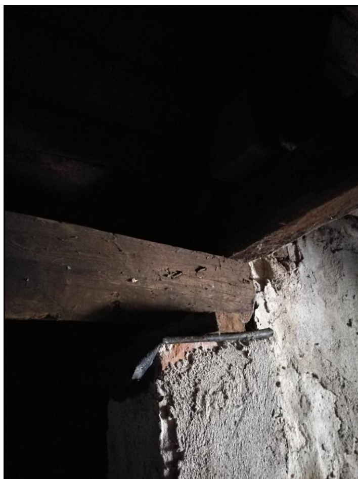
Fot. 27 Oparcie zapadającej się płatwi na fragmencie komina
