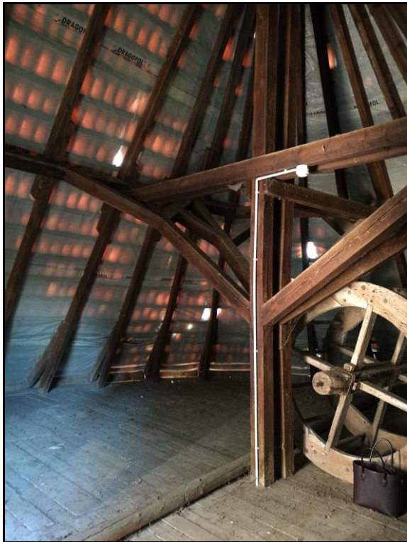
Fot. 4 Baszta Kustodii- widok poddasza i konstrukcji więźby dachowej
