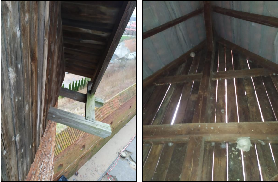
Fot. 17,18 Fragment odeskowań zewnętrznych (ściana wschodnia oraz odeskowanie połaci)
