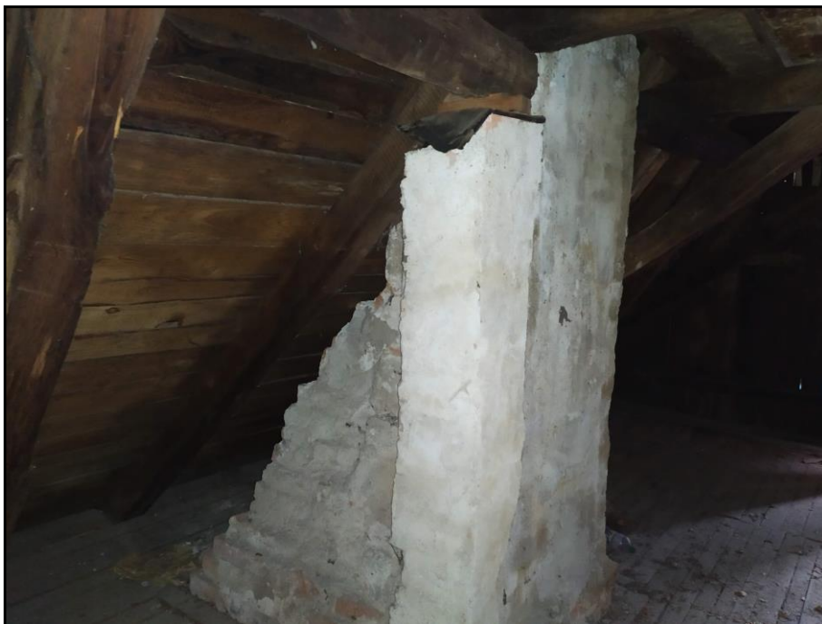
Fot. 26 Konstrukcja komina w części północnej poddasza
