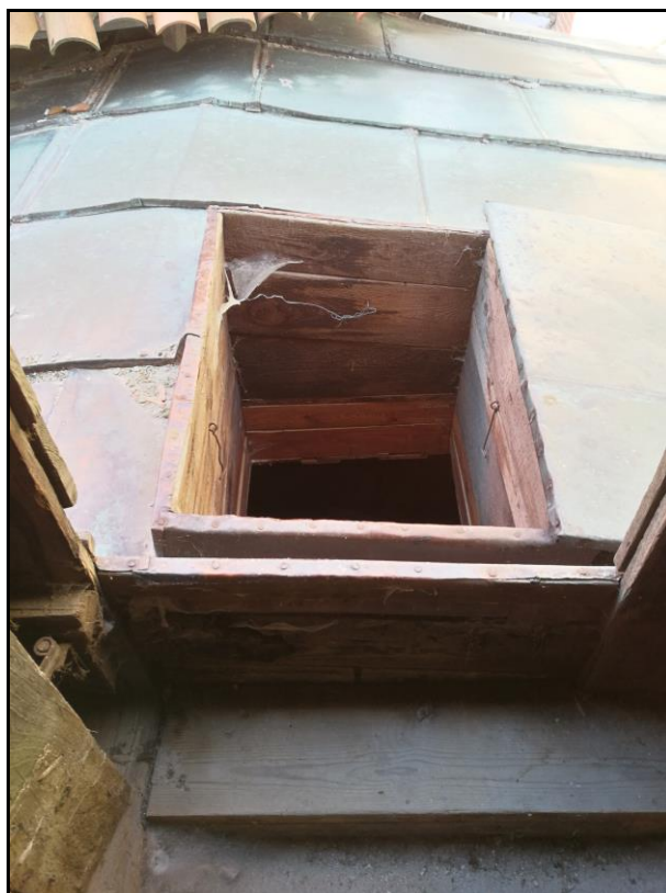
Fot. 31 Istniejący wylaz na stropodach
