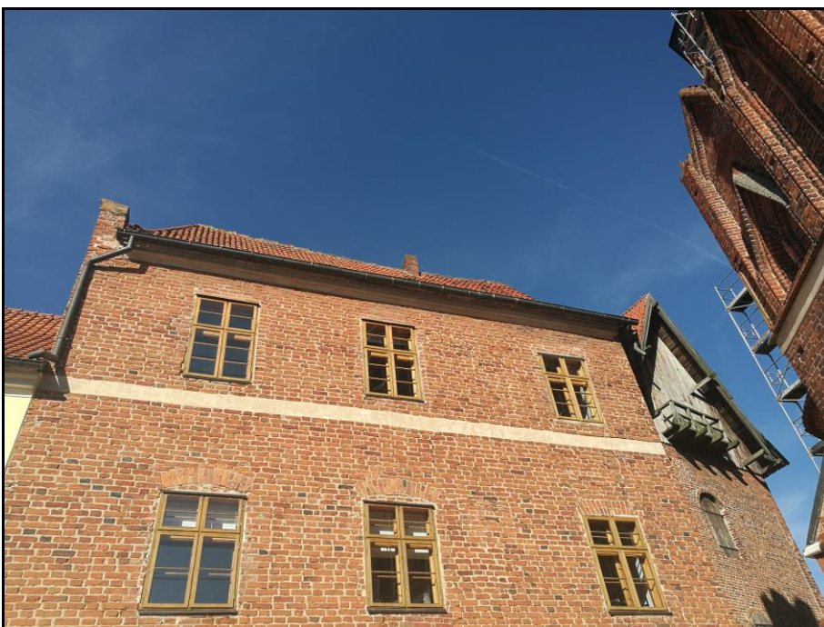
Fot. 8 Widok południowej części okapowej Domu Kustosza oraz szczytu południowego Baszty Kustodii
