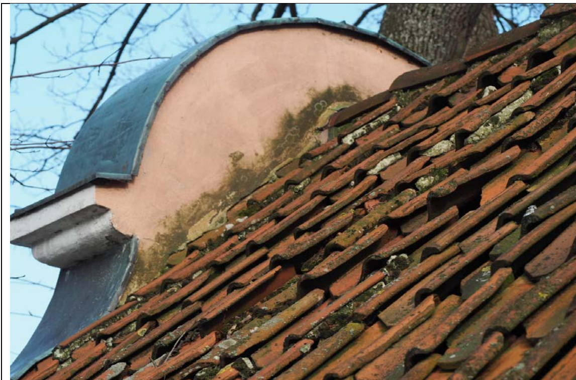
Fot. nr 6. Kaplica św. Jerzego. Stan zachowania pokrycia dachowego po stronie zachodniej.
