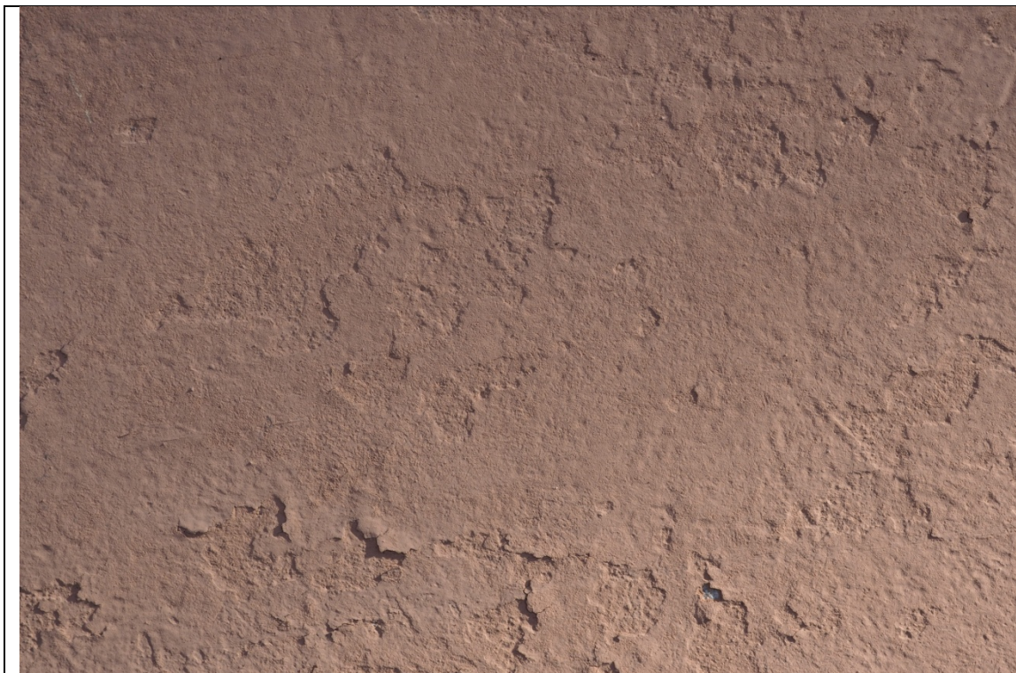
Fot. nr 12. Kaplica św. Jerzego. Lico ściany z widocznymi kilkoma powłokami farb.
