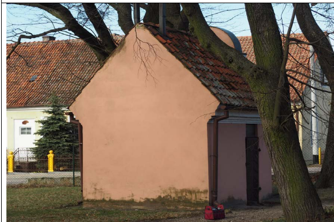
Fot. nr 3. Kaplica św. Jerzego. Ściana południowa i wschodnia.
