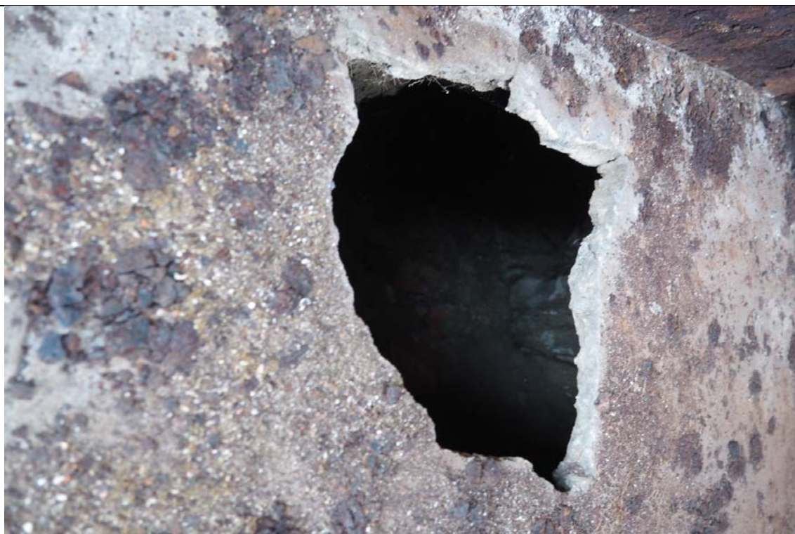
Fot. nr 22. Kaplica św. Jerzego. Zbliżenie betonowej posadzki.
