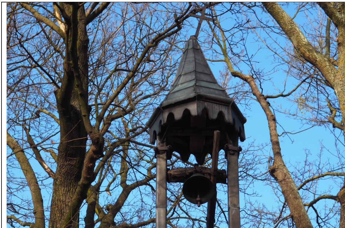
Fot. nr 8. Kaplica św. Jerzego. Sygnaturka.
