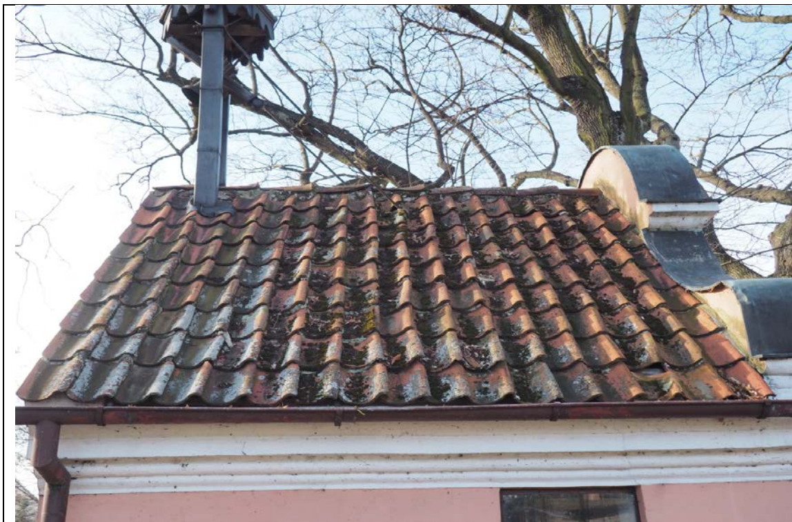
Fot. nr 4. Kaplica św. Jerzego. Gzyms i dach od strony wschodniej .
