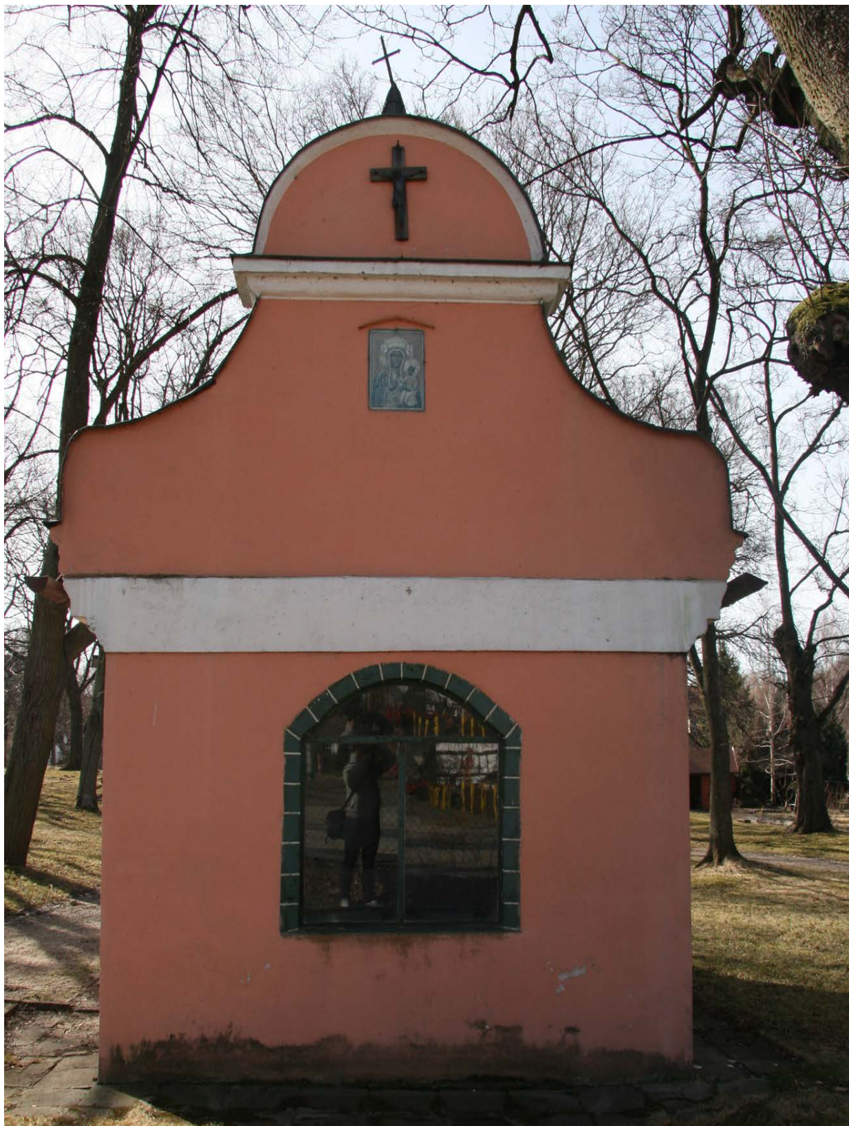
Fot. nr 1. Kaplica św. Jerzego. Elewacja północna.
