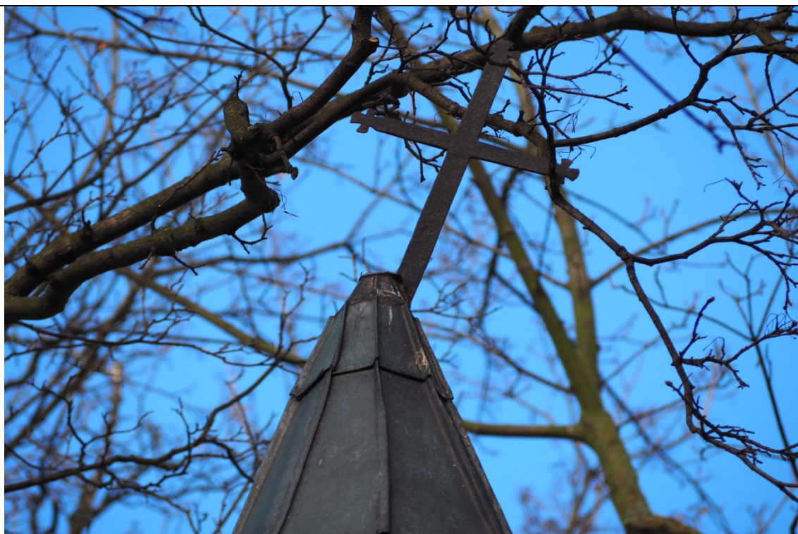
Fot. nr 9. Kaplica św. Jerzego. Zwieńczenie sygnaturki z przekrzywionym krzyżem.
